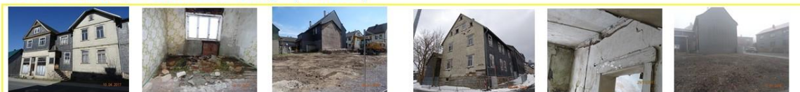
2 Beispiele aus dem Modellraum für sog. „Schrottimmobilen“, Die privaten Eigentümer sind ihren Pflichten nicht nachgekommen. Der Komplettabriss musste durch den Landkreis auf Grund der Gefährdung der öffentlichen Sicherheit vollzogen werden. Beide Fälle werden derzeit im Bereich KOMET-Leerstandsmanagement bearbeitet. (Fotos: LRA IK, UBAB)
